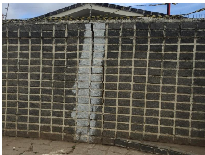
Figura 6 – “Rachadura” em calçamento e muro de residência. Nota-se afundamento do bloco do lado esquerdo da foto, em direção à Lagoa Mundaú.
