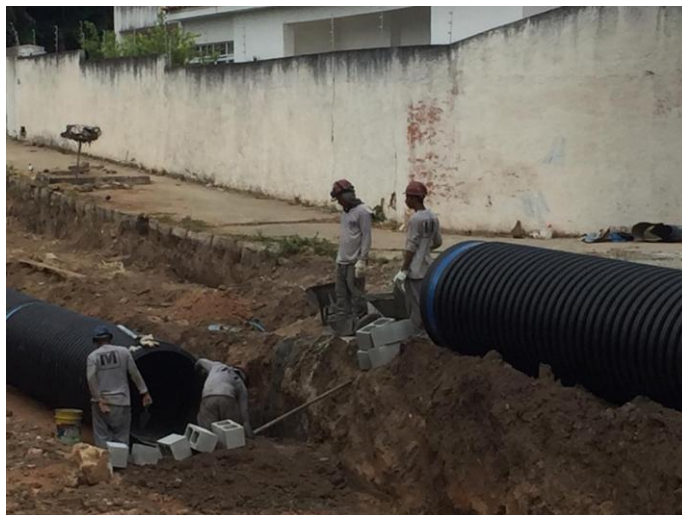
Figura 10 – Reparo na tubulação de água, no Bairro Pinheiro, com colocação de tubos de material flexível, procurando evitar novo rompimento.
