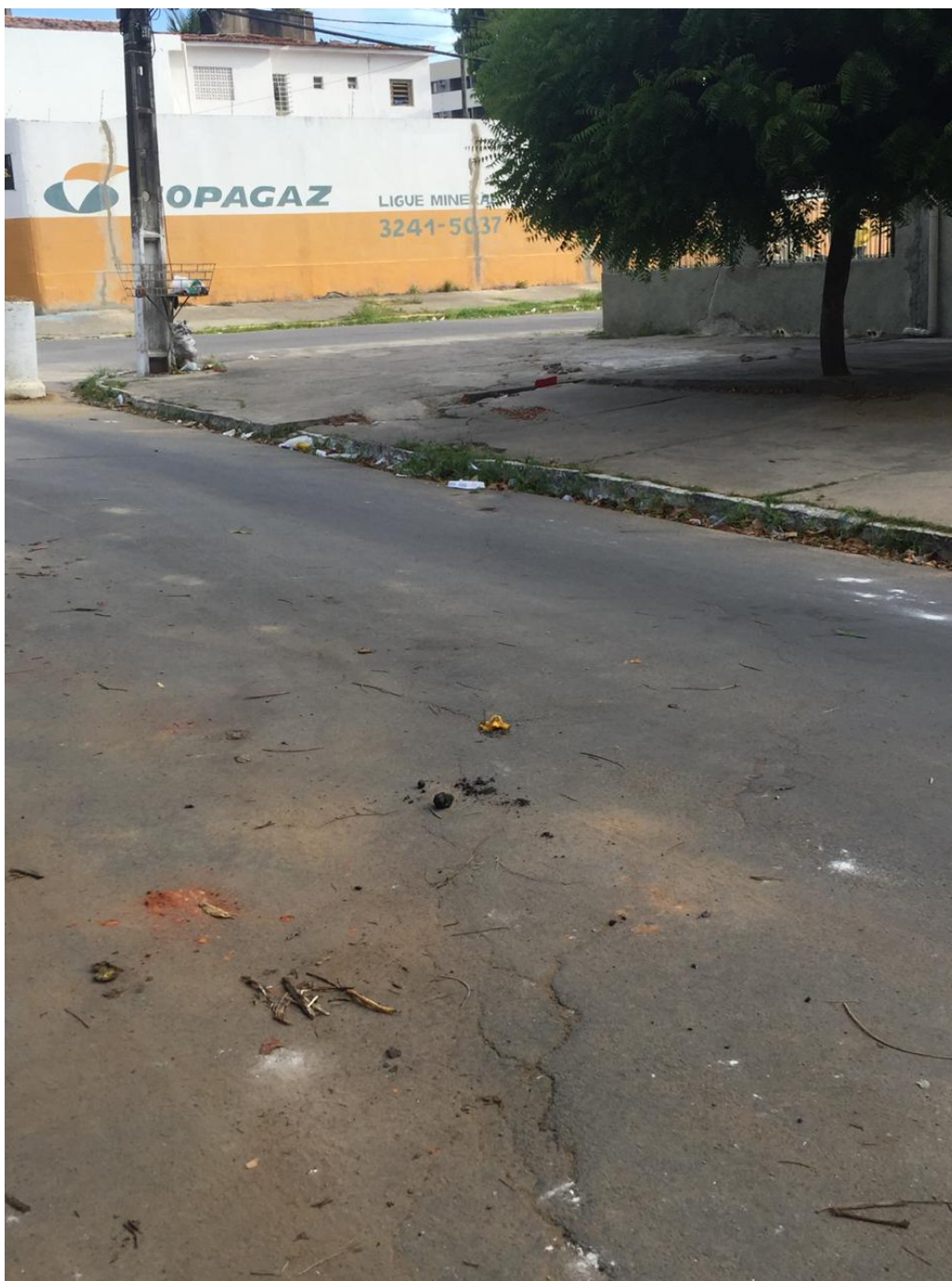
Figura 7 – “Rachaduras” piso asfáltico, em primeiro plano, que têm continuidade em calçamento e muro de distribuidora de gás, ao fundo, onde foram reparados.
