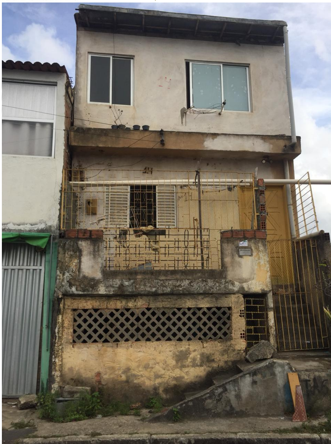
Figura 9 – Residência adernada para a esquerda, com afundamento do bloco do lado direito da foto, em direção à Lagoa Mundaú.
