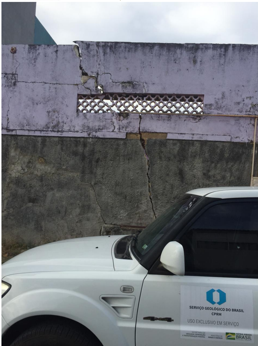
Figura 8 – “Rachadura” em muro de residência. Nota-se afundamento decimétrico do bloco do lado esquerdo da foto, em direção à Lagoa Mundaú.
