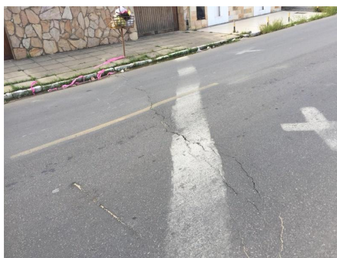
Figura 3 – “Rachadura” em piso asfáltico, no Bairro Pinheiro, com porção à esquerda mostrando afundamento centimétrico com relação à da direita. O Afundamento se dá na direção da Lagoa Mundaú. Este comportamento indica a presença de uma falha normal ou de gravidade.
